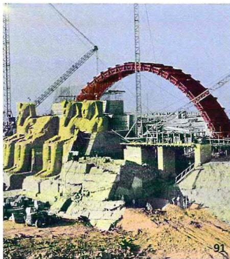
In höchst spektakulärer Aktion wurden die einzigartigen Tempel komplett in bis zu 30 Tonnen schwere Würfelblöcke zersägt und an höherer Stelle wieder originalgetreu zusammengefügt.
